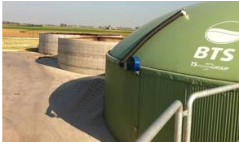
● Il biodigestore dell'azienda Cazzola non raggiunge la piena potenzialità produttiva a causa dell'assenza di un trituratore di materie prime.
